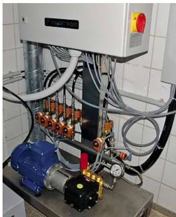
Von der Zentraleinheit der Hochdruck-Luftbefeuchtung werden sechs Räume versorgt.
