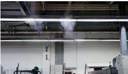
In acht verschiedenen Zonen in sieben Produktionsbereichen wird bei Bonifatius mit der Luftbefeuchtung von Finestfog seit September 2013 ein optimales Raumklima auf energieeffiziente Art und Weise geschaffen.
