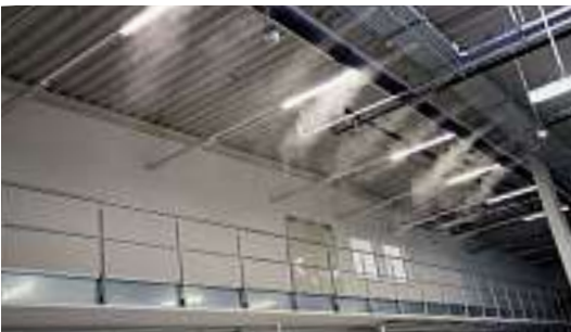
Mit insgesamt 50 Düsen in vier Sektionen verschafft die Finestfog-Anlage ein angenehmes Raumklima mit idealer Luftfeuchtigkeit von 50 Prozent. Zudem sorgt das zentrale System für die Wasseraufbereitung per Umkehrosmose.
