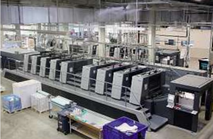
Blick in die Produktionshalle von oeding print, wo Finestfog durch unter der Decke angebrachte Hochdruckdüsen für eine Direktvernebelung sorgt.
