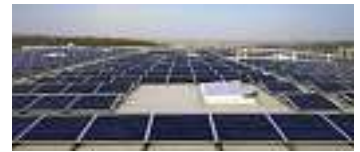
Das 2013 neu errichtete Firmengebäude der oeding print GmbH ist mit Blockheizkraftwerk und Photovoltaik-Anlage ausgerüstet, die in der Energiebilanz ein Plus erreichen.
