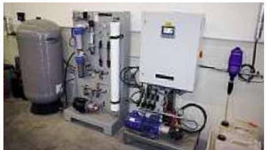
Mit insgesamt 50 Düsen in vier Sektionen verschafft die Finestfog-Anlage ein angenehmes Raumklima mit idealer Luftfeuchtigkeit von 50 Prozent. Zudem sorgt das zentrale System für die Wasseraufbereitung per Umkehrosmose.
